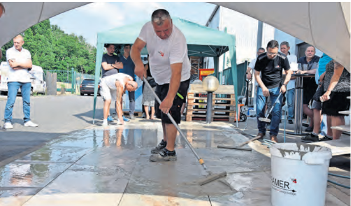
Dass das Verfugen mit dem wasserdurchlässigen Fugenmörtel von tubag kein Hexenwerk ist, zeigten die Mitarbeiter eindrucksvoll.
