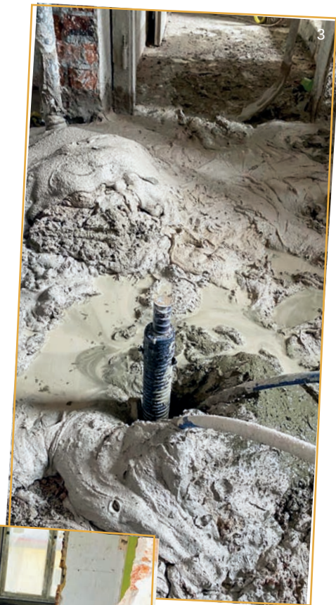
▲ Mit schwerem Gerät wurden die Micro-Bohrpfähle schließlich mechanisch gebohrt.
