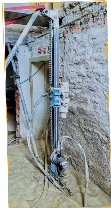
▲ Die ursprünglich geplante Spülbohrung funktionierte aufgrund des Baugrundes nicht wie gewünscht.
