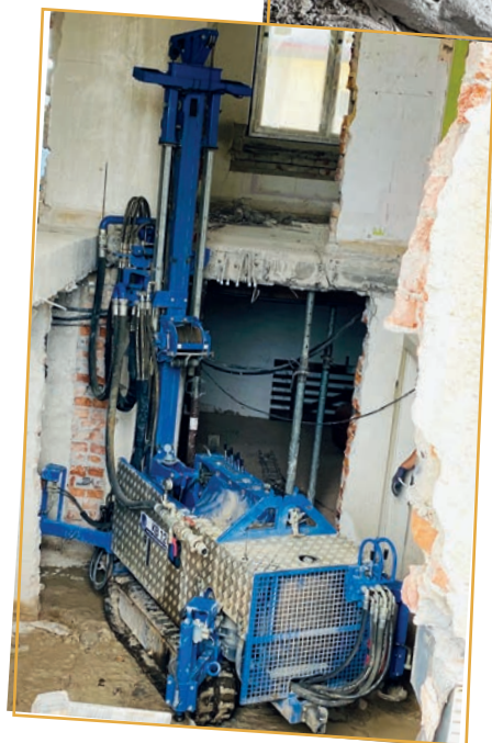
▲ Mit schwerem Gerät wurden die Micro-Bohrpfähle schließlich mechanisch gebohrt.
