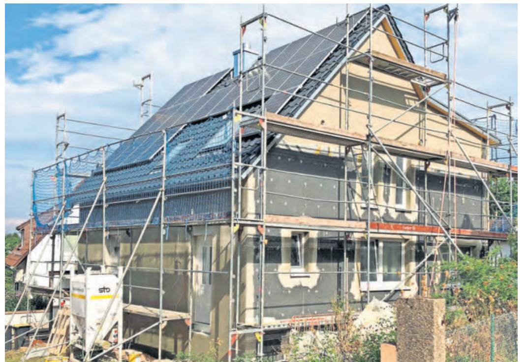
Die Gebäudehülle dämmen, neue Fenster einbauen. So werden immerhin schon mal 80 Prozent der Klimaziele erreicht. Fotos: Bundesverband Gebäudemodernisierung e.V.
