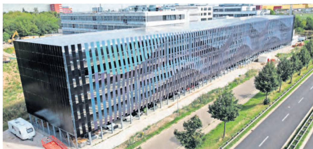
DCIM101MEDIADJL_0093.JPG Die elektroBau Dresden montierte die Solarmodule am DHL-Parkhausgebäude am Schkeuditzer Kreuz. Foto: Avancis
