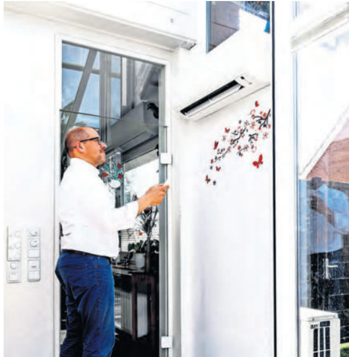
Effiziente Luft-Luft-Wärmepumpen in Form einer Klimaanlage können eine vorhandene Gasheizung sinnvoll ergänzen. Foto: djd/www.daikin.de
