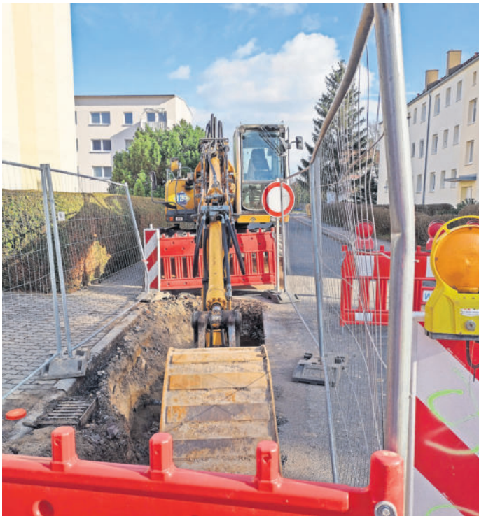
Die Döbeln-Oschatzer Wasserwirtschaft GmbH (DOWW) erneuert derzeit in der Mügeln Neuen Straße die Trinkwasserleitung im Bohrspülverfahren. Foto: Tobias Ehlers
