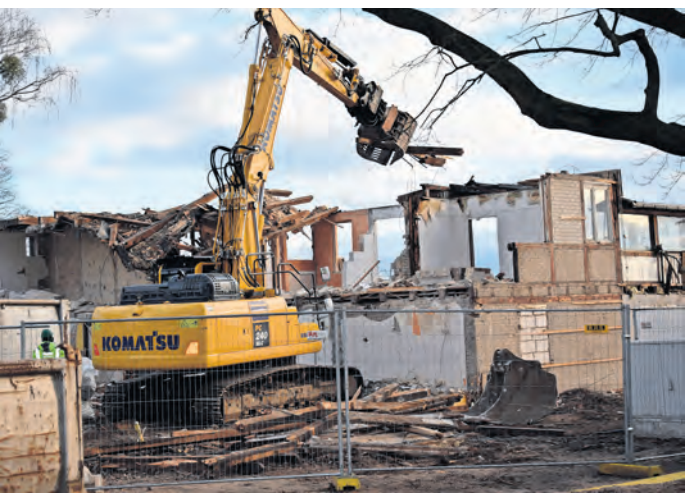
Ein lokales Unternehmen nahm sich dem Abriss an. Fotos: SWB/HL
