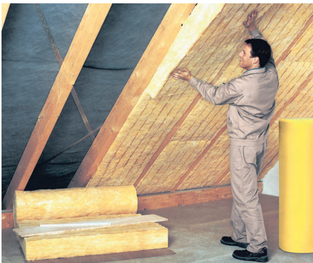
Eine Dämmung mit Mineralwolle, also Glas- und Steinwolle, hilft, den benötigten Energiebedarf des Hauses stark zu reduzieren. Foto: PR
