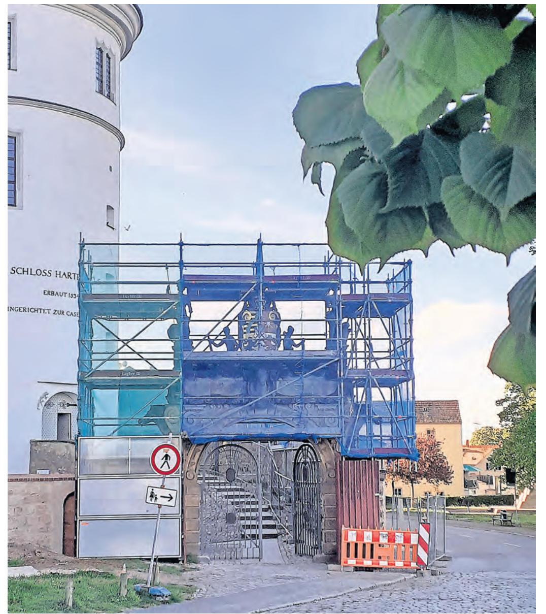
Eingerüstet ist aktuell das Jägertor. Foto: SWB/HL
