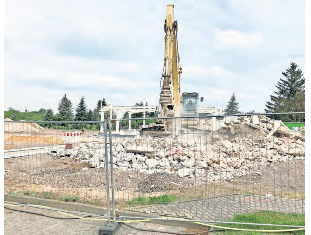
Mit einem großen Bagger wurde auf dem Gelände in der Dahleiner Bahnhofstraße Baufreiheit geschaffen. Vorher befand sich hier das Autohaus Dahlen.
