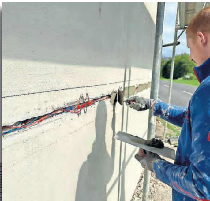
Das Aufsticken eines Carbonroving auf einen konventionellen Putzträger in diesem Fall Glasfasergewebe.
