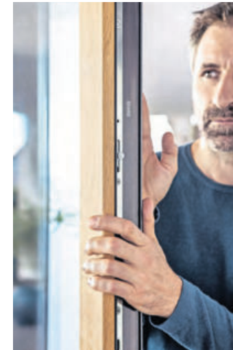
Sitzt alles noch fest? Fenster sollten regelmäßig überprüft, gereinigt und in Teilen auch nachgefettet werden. Foto: djd/REHAU Industries
