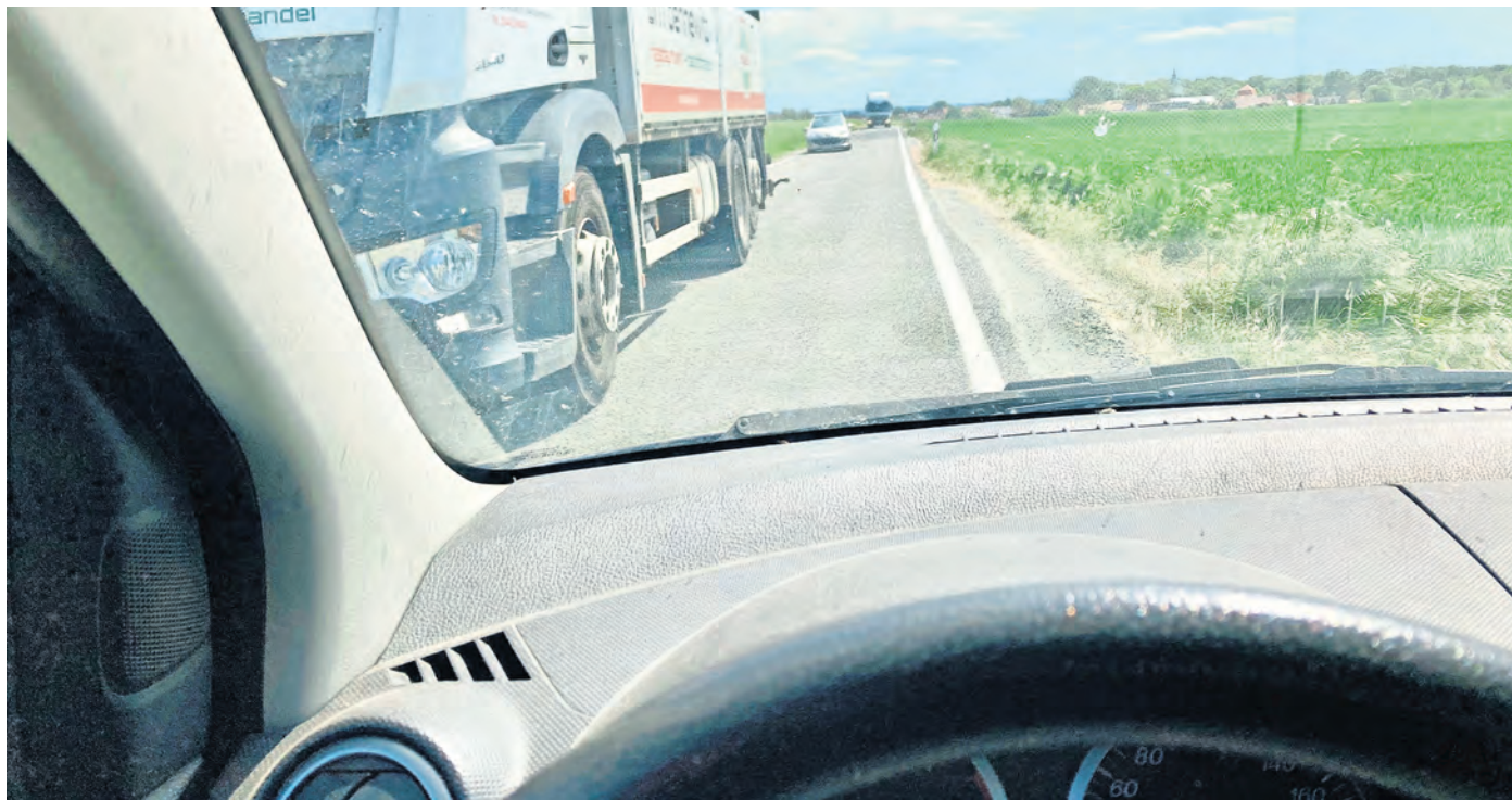
Die Umleitung um Schmannewitz: An manchen Stellen ist die Straße so schmal, dass Fahrzeuge kaum aneinander vorbei fahren können. Die Randstreifen sind deshalb bereits stark ausgefahren. Foto: Hagen Rösner
