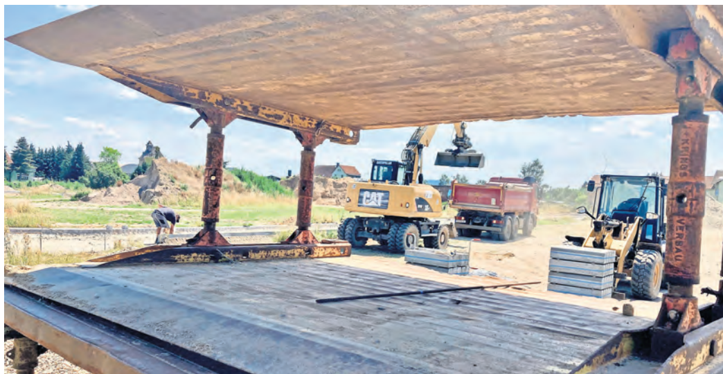
Zurzeit werden an der Hainstraße in Dahlemer die Erschließungsstraßen für den neuen Eigenheimstandort gebaut. Das neue Wohngebiet hat einige Besonderheiten, die für Häuslebauer interessant sein könnten. Foto: Hagen Rösner
