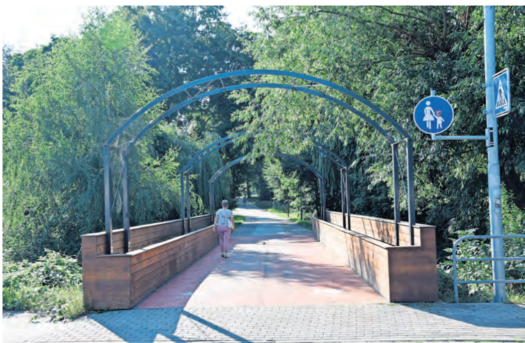
Seit vergangenen Mittwoch wird die Fußgängerbrücke vom Bahnhof in Richtung Torgauer Innenstadt abgerissen. Bis 13. Dezember soll der Ersatzneubau fertig sein. Foto: SWB/HL
