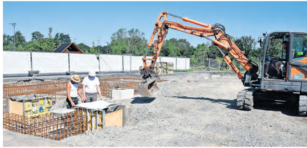
Die Fachleute der Matthias Tröppen Bauunternehmung GmbH aus Roitzsch kommen gut voran.
