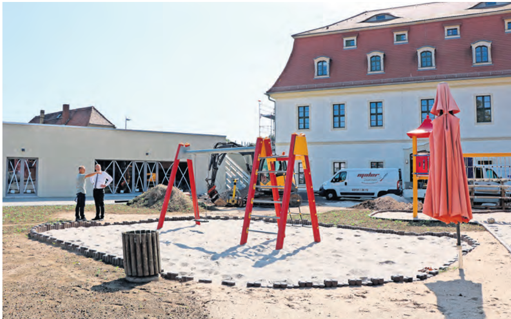
Der Anbau ist fertig und die ersten Spielgeräte sind bereits montiert: Die Arbeiten am künftigen Schulhort in Wermisdorf gehen wie geplant vorwärts. 3,2 Millionen Euro werden hier investiert.
