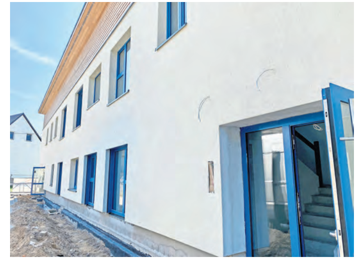
Baustelle Nummer 2: die neue Kita in Mahlis. Foto: Jana Brechlin
