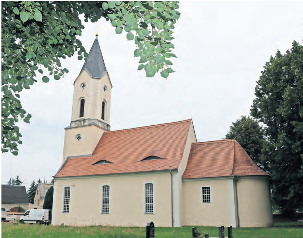
Nach der aufwendigen Sanierung präsentiert sich die Sörnewitzer Dorfkirche als Schmuckstück. Abschließend soll noch die kleine, vom Eilenburger Orgelbaumeister Nikolaus Schrickel 1859 geschaffene Orgel instand gesetzt werden. Foto: Jana Brechlin
