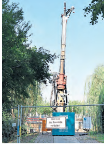
Die Gründungsarbeiten für die beiden neu zu errichtenden Widerlager der Fußgängerbrücke zum Bahnhof haben begonnen. Foto: SWB/HL
