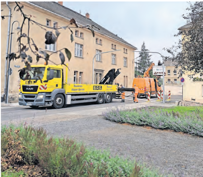
Die fehlenden Peitschenauslegern wurden am Mittwoch aufgestellt.
