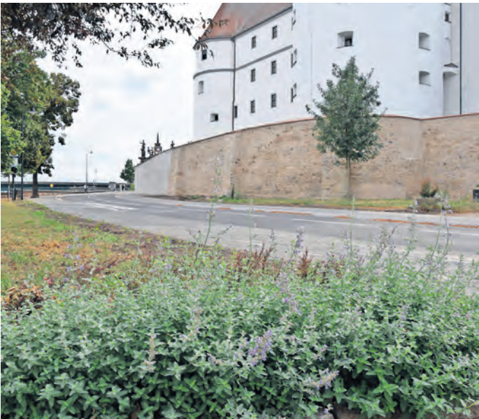
Noch ist die Elbstraße gesperrt. In der Woche ab dem 23. September soll der Verkehr wieder fließen.
