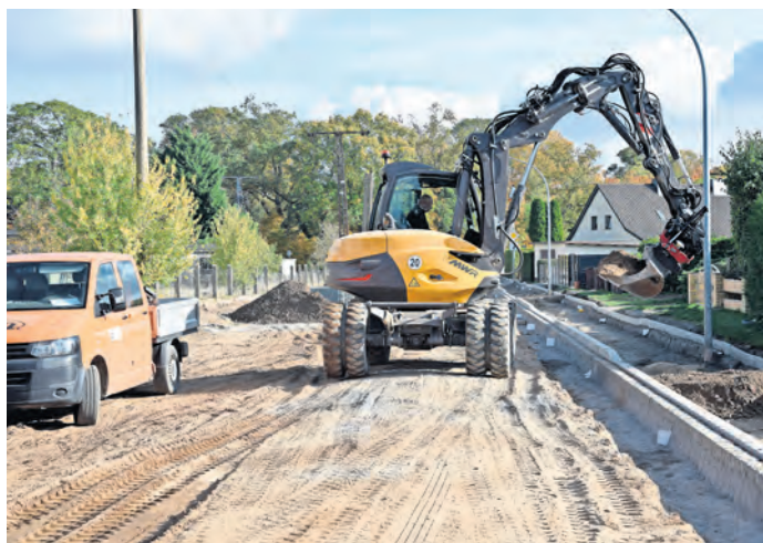
Die Bauunternehmung EZEL Torgau GmbH leistet ganze Arbeit bei der Sanierung der S 25 in Packisch. Foto: SWB/HL
