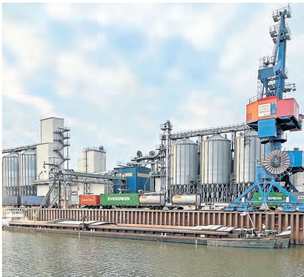
Der Neubau des Containerterminals im Hafen Riesa soll wieder mehr Verkehre auf den umweltfreundlichen Verkehrsträgern Wasser und Schiene ermöglichen. Foto: SBO
