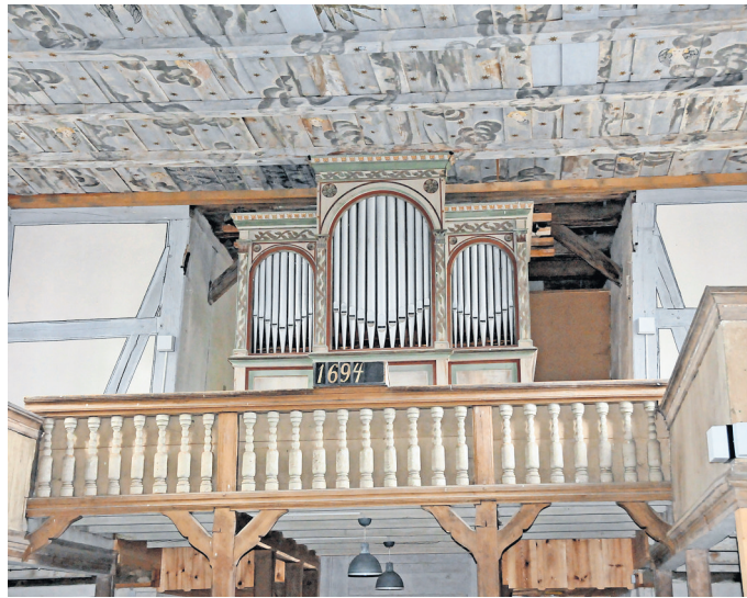
Die Röver-Orgel in Blumberg wird saniert.
