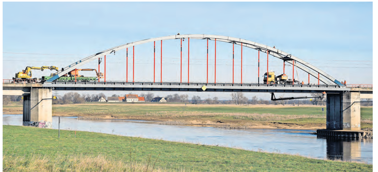
Gesperrt ist der Bahnübergang Döbernsche Straße in Torgau, weil es Gleisbauarbeiten auf der Strecke Leipzig - Cottbus gibt, die Schienenersatzverkehr nötig machen. Bis einschließlich 9. März machen sich Umwege erforderlich. Fotos: SWB/HL
