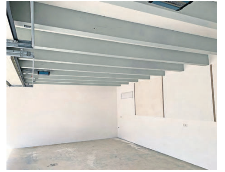
Untersicht der fertigen HBV-Decke.
