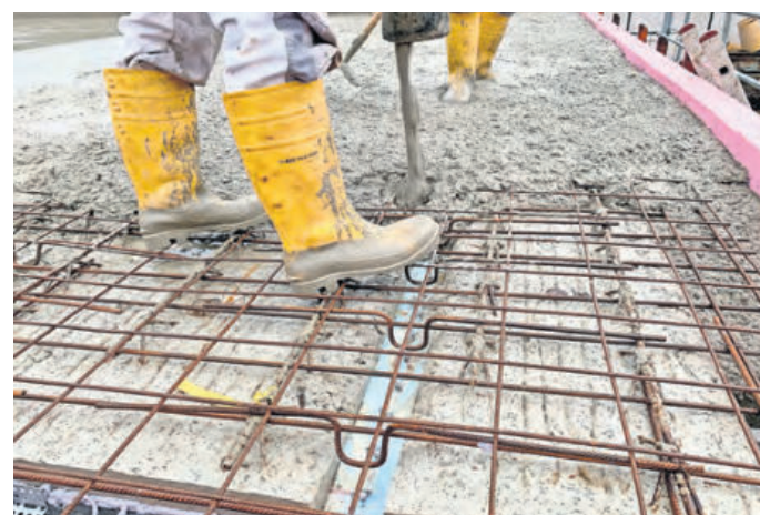
Herstellung einer HBV-Platte bestehend aus Holzbalken mit Verbundschrauben und einer darauf aufgetragenen Betonplatte in Halbfertigteilbauweise.
