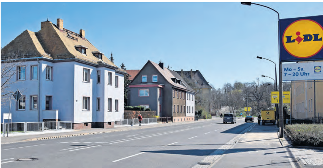
Ab 14. April wird die Warschauer Straße in Torgau für Baumaßnahmen gesperrt. Die Verkehrsführung wird neu geordnet.
