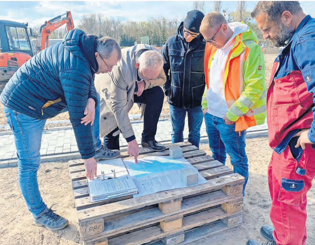
Expertenrunde bei der wöchentlichen Bauberatung vor Ort auf dem Areal des künftigen Kunstrasenplatzes. Detailfragen werden verschiedene Phasen der Projektrealisierung besprochen, abgestimmt. Unter anderem ging es zuletzt um die Linierung für den Platz nach Vorgaben der künftigen Nutzer vom SCH und dem TSV Blau-Weiß.
