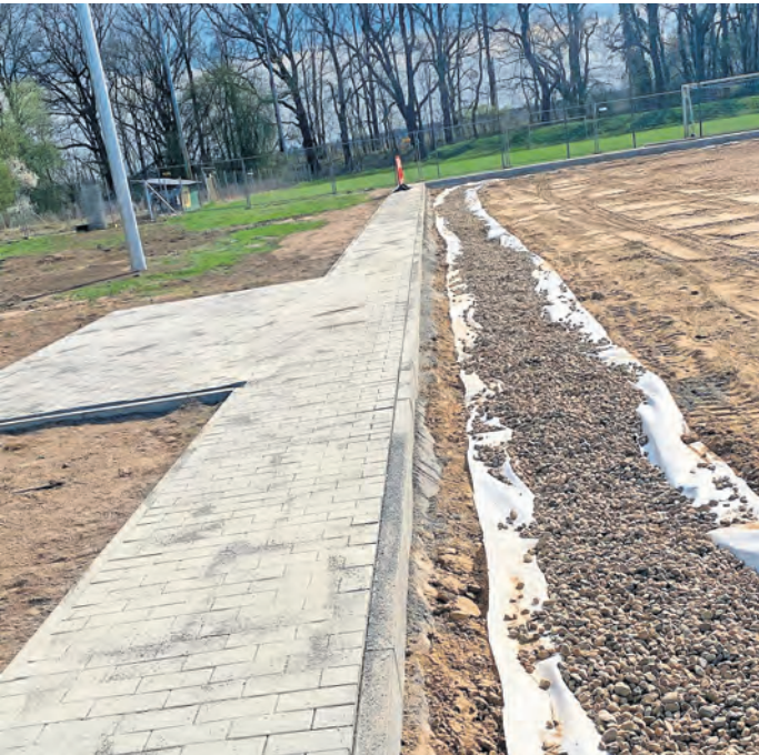
Mittlerweile erledigt sind die Pflasterarbeiten am Rund-Um Weg und das Setzen der Masten für den umgebenden Zaun. Nach Osten soll dann auch das moderne Flutlicht installiert werden, dass aus etwa 16 Metern Höhe für beste Sichtmöglichkeiten sorgt.
