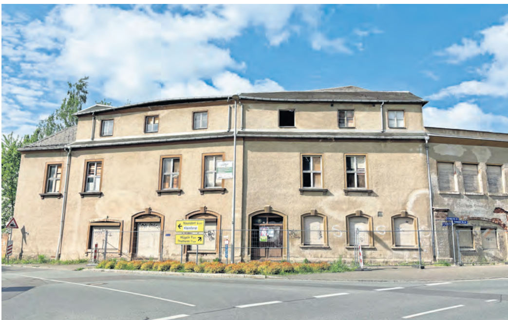
Der Gasthof in Altoschatz soll abgerissen werden. Die Fläche wird anschließend nicht wieder bebaut. Fotos: Jana Brechlin
