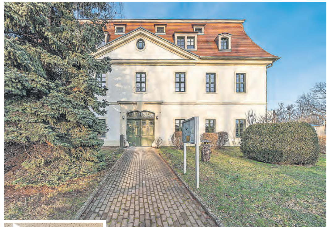
Das Hortgebäude in der denkmalgeschützten „Alten Post“ in Wermsdorf wurde saniert und erhielt einen Erweiterungsbau. Am Samstag können Architekturinteressierte das Entstandene bei Besichtigungen und Führungen in Augenschein nehmen.
