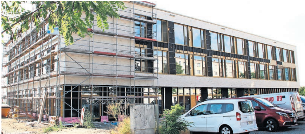
Der Neubau der Grundschule Magister Hering in Oschatz ist weit vorangeschritten, es gibt aber noch einiges zu tun. Foto: Frank Höriguel
