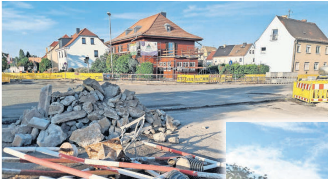
Die Kreuzung Warschauer- und Naundorfer Straße gleicht noch einer Großbaustelle. Die Überleitung des Radverkehrs wird noch konzipiert. Fotos: SWB/HL
