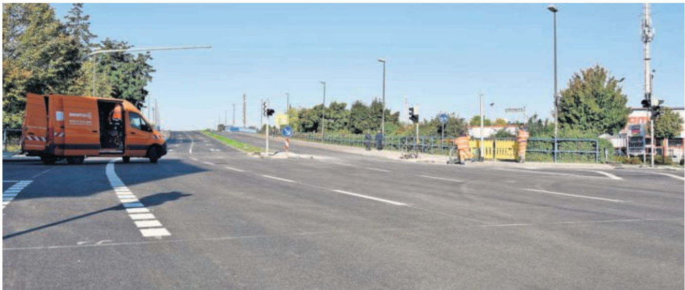
Am Dienstag wurden noch Restarbeiten der verschiedenen Gewerke durchgeführt.
