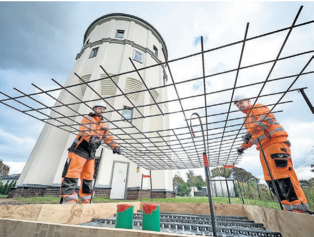
Am Wasserturm Leisnig haben die Veolia-Mitarbeiter Robby Thomas und Jens Möckel (l.) das Fundament für das Notstromaggregat errichtet, das hier installiert werden soll. Foto: Heiko Rebsch/Veolia
