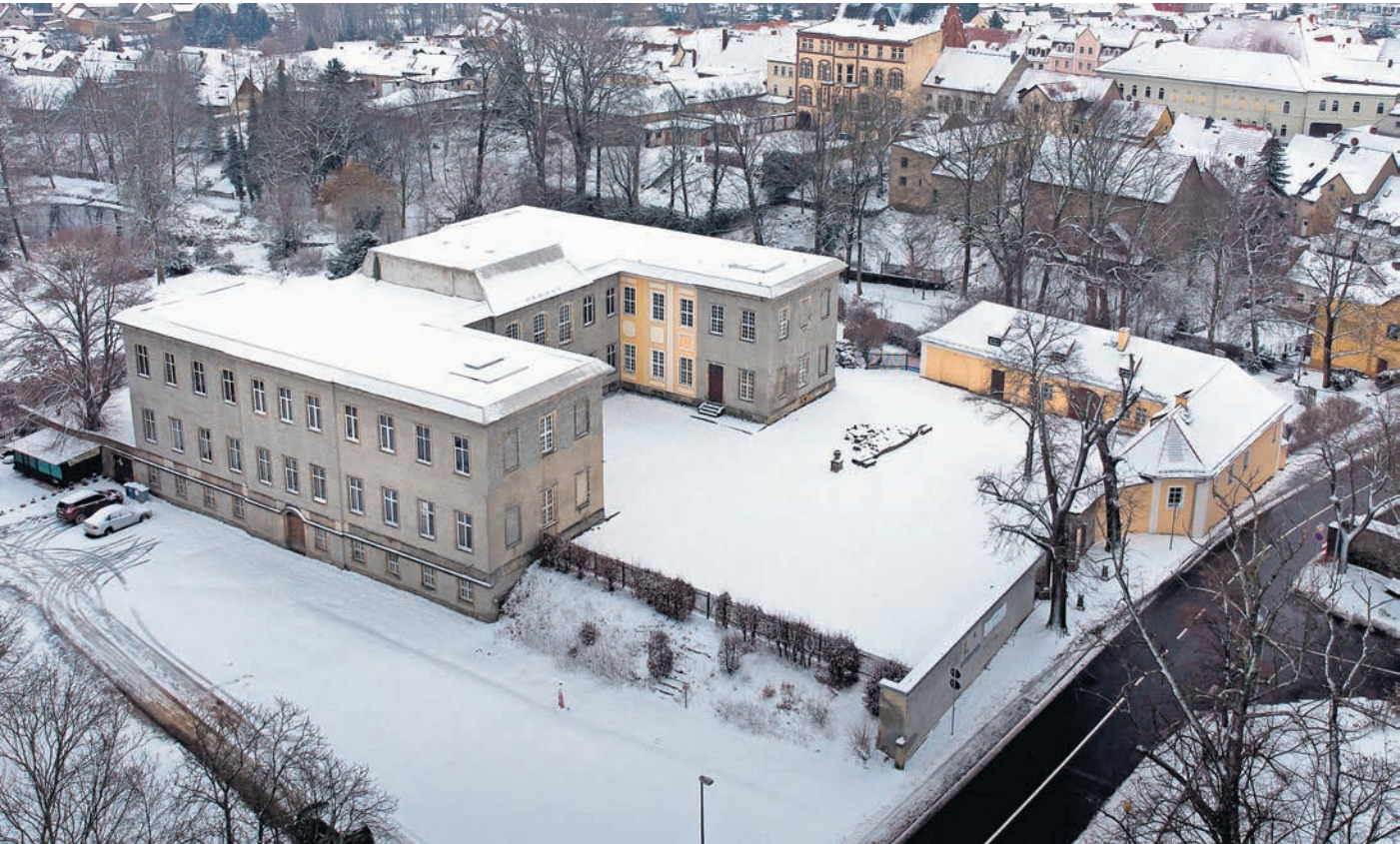
Auf dieser Luftaufnahme vom Schloss Dahlen säumen noch die alten Linden die Toranlage. Diese soll nun mit Geld der Sparkassenstiftung notgesichert und rekonstruiert werden. Foto: Wolfgang Sens
