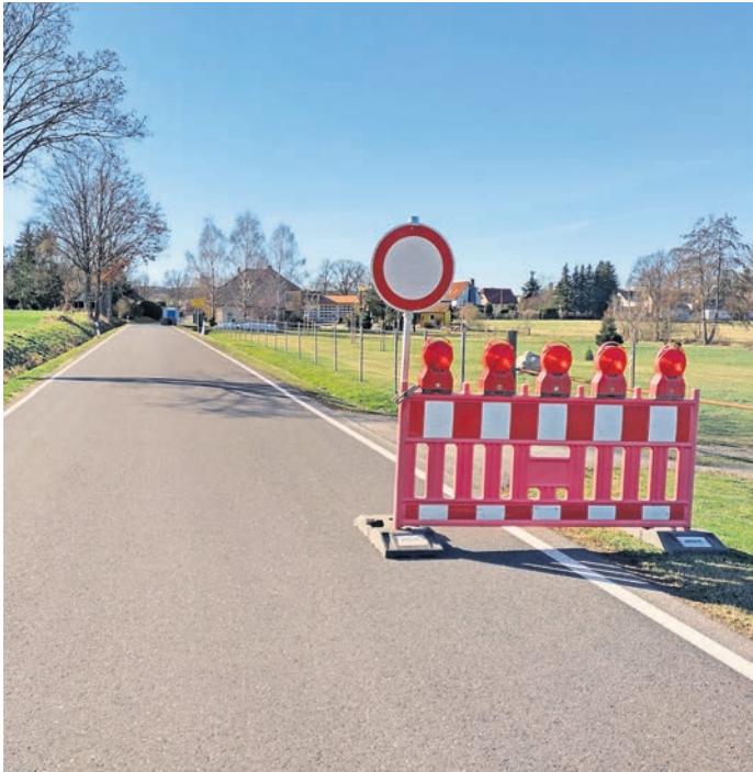
Wegen der Verlegung der neuen Trinkwasserleitung ist die Ortsdurchfahrt Limbach derzeit gesperrt. Foto: Torsten Richter
