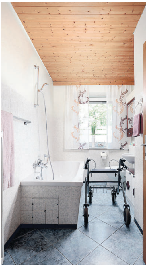
Ausgangssituation vor der Renovierung – ein Bad mit Wanne und hohem Einstieg. Der schmale Grundriss lässt eine Nutzung mit Gehhilfe kaum zu.
