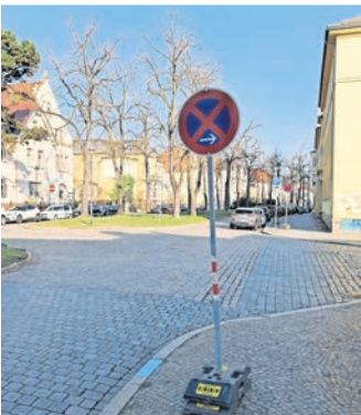
Die Errichtung eines neuen Bauwerks im Kreuzungsbereich August-Bebel-Straße / Unruhstraße führt zu Verkehrseinschränkungen.
