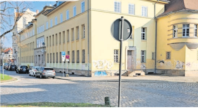
In drei Bauabschnitten wird ab kommenden Montag im Kreuzungsbereich August-Bebel-Straße / Unruhstraße gebaut. Fotos: SWB/HL
