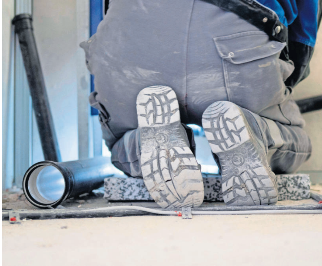
HANDWERKERAUFTRÄGE sollten an eingetragene Fachbetriebe vergeben werden: Haustürgeschäfte sind riskant und oft teuer. Foto: Marijan Murat/dpa/dpa-mag
