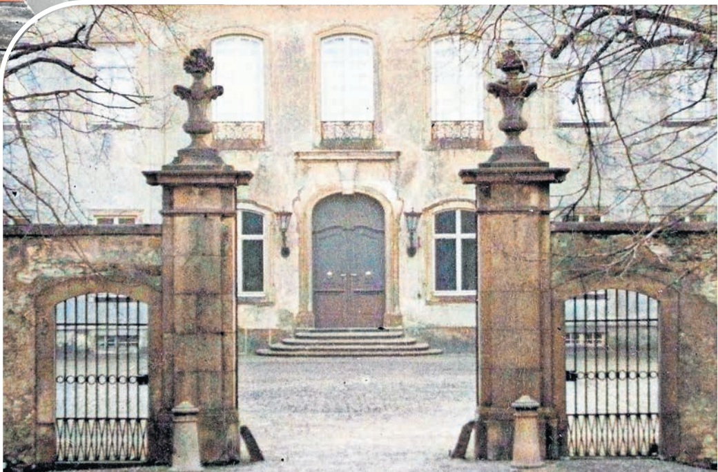
Diese historische Aufnahme zeigt das Eingangsportal mit den beiden Sandsteinvasen zur Bekrönung. So soll das Tor jetzt wiederhergestellt werden. Foto: Schloss Dahleener
