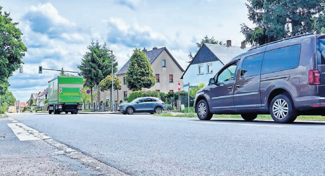
Die B6 in Calbitz wird wegen Arbeiten an der Straßendecke voll gesperrt. Für Pendler bedeutet das, mehr Zeit für den Arbeitsweg einplanen. Foto: Jana Brechlin
