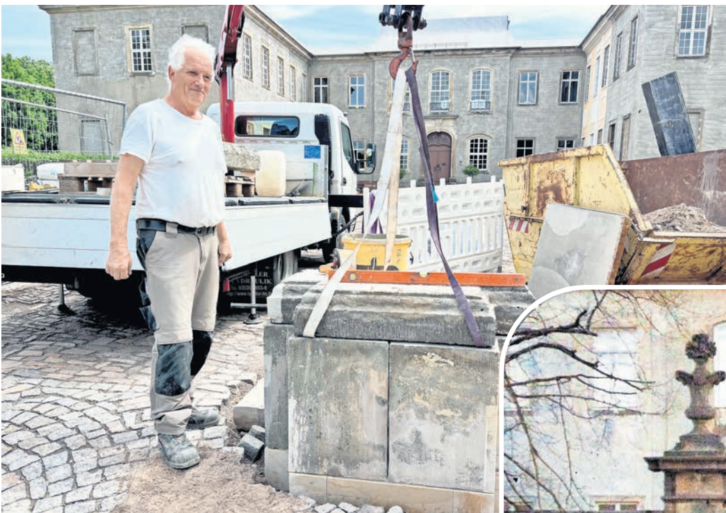
Steinmetzmeister Johannes Heischmann übernimmt die Rekonstruktion der Säulen am Schlossportal in Dahlen und verwendet dabei möglichst originale Sandsteinteile. Foto: Jana Brechlin
