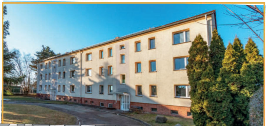
▼ Außenansicht vor Sanierungsbeginn und Grundrisse
