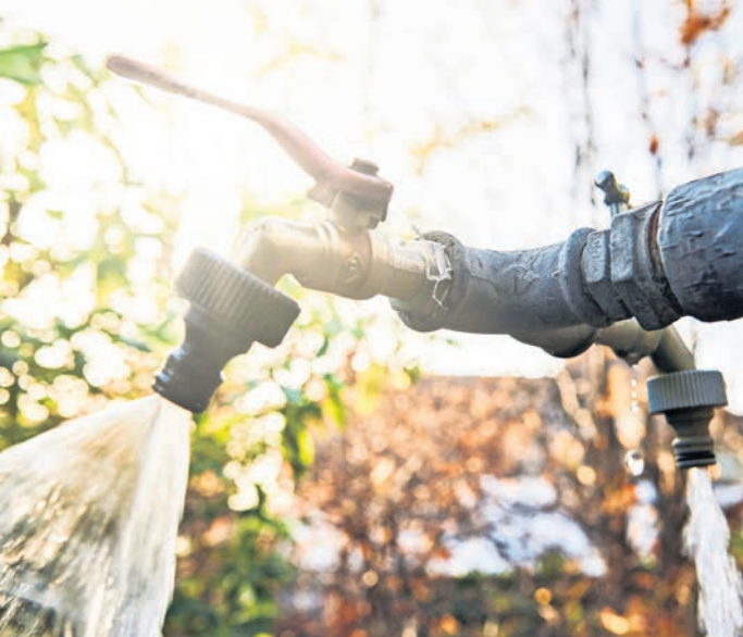
Für die Sicherheit der Trinkwasserversorgung werden im Bereich Oschatz und Döbeln in diesem Jahr noch einige Baumaßnahmen abgeschlossen.
