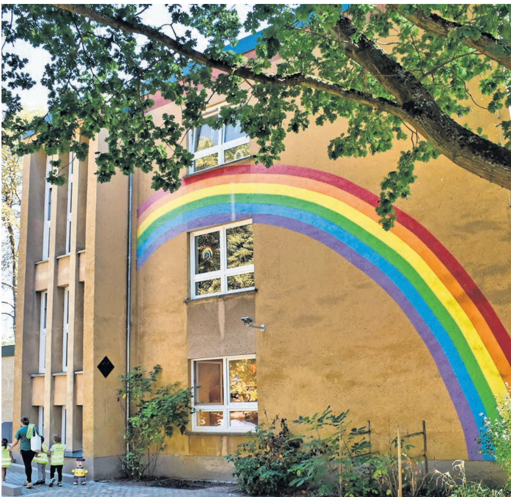
Die Kindertagesstätte Regenbogen in Grimma-Süd wurde seit Frühjahr 2025 saniert. Stadt Grimma
