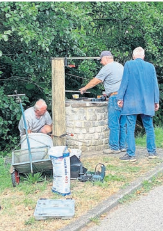
Einwohner von Sornzig haben den historischen Brunnen an der Hauptstraße ehrenamtlich instand gesetzt. Foto: privat
