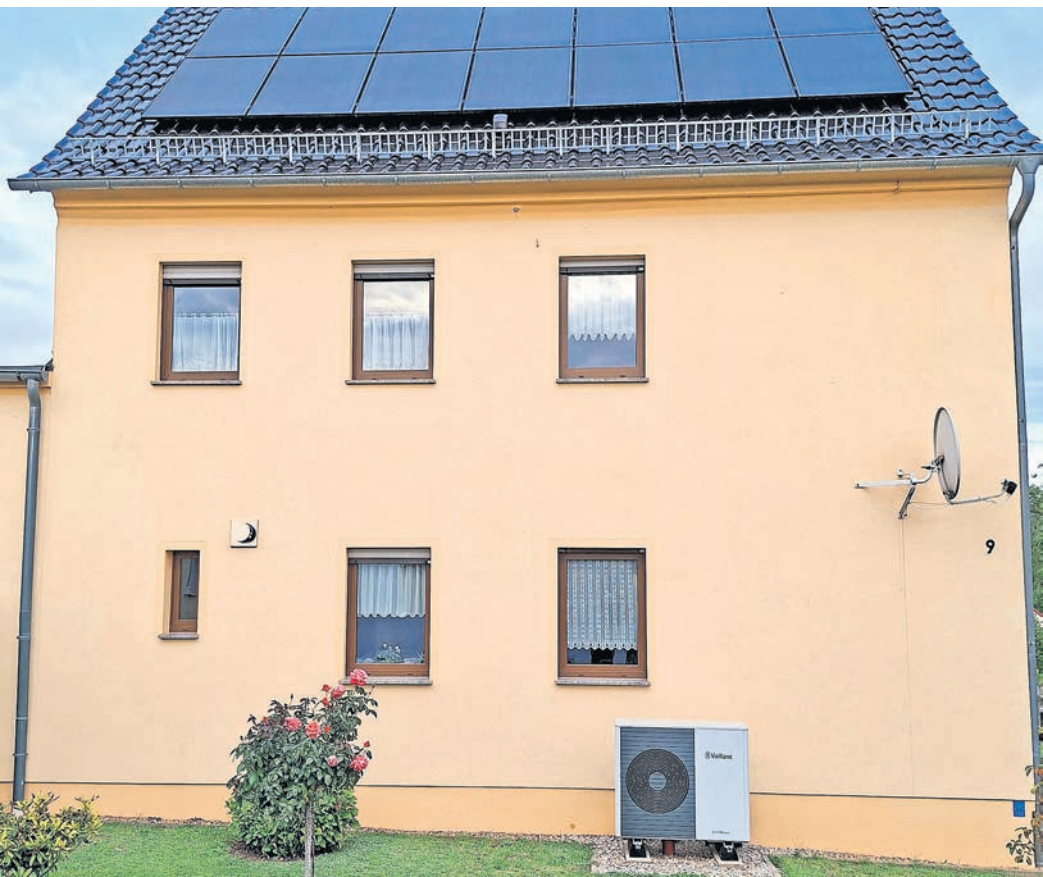
Maximale Effizienz zur Senkung der Energiekosten: Saniertes Dach mit PV-Anlage in Verbindung mit einer Wärmepumpe. privat
