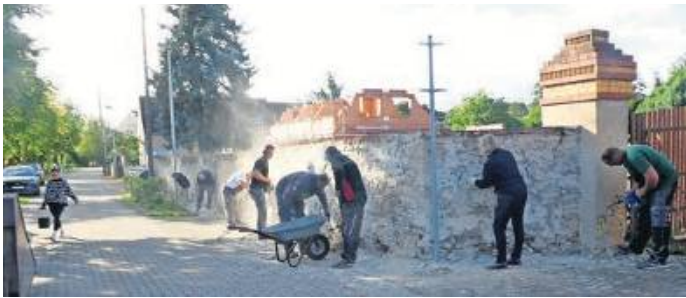
Voller Einsatz: Die Dorfgemeinschaft hilft aktiv bei der Sanierung der denkmalgeschützten Pfarrhausmauer. Foto: privat
